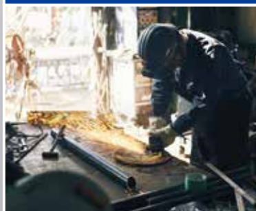
高温の作業現場で
